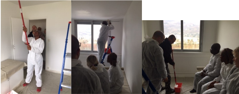
Peinture du logement (février 2020)
