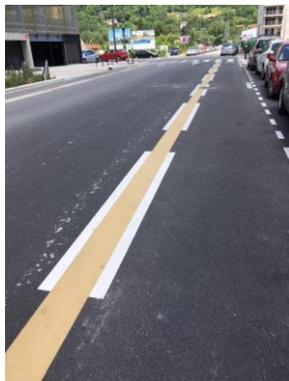
← **Nouveau standard Métropole :** Exemple de bande cyclable généreusement délimitée pour sécuriser les vélos et mieux les séparer des véhicules routiers.
